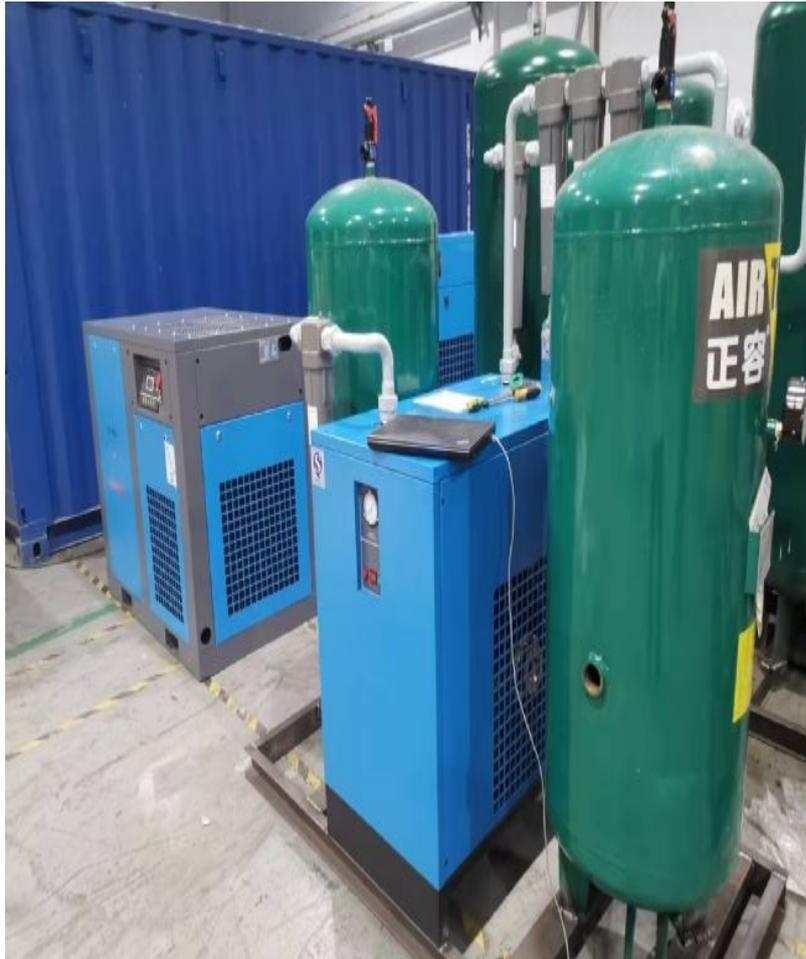
苏州希特已经为食品包装安装了 50 m<sup>3</sup>/h 的制氮机，纯度为 99.9%，工作压力为 6 KG/CM<sup>2</sup>。
